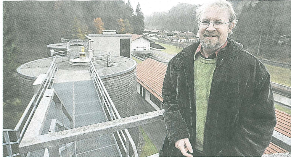
Eine wirtschaftlichere Kläranlage wünscht sich Zweckverbands-Betriebsleiter Alfred Kölbl. Energiespar-Potenziale sind durchaus vorhanden.
